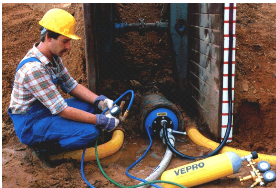
Prueba hidráulica en una tubería
